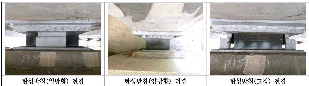
【사진 1.3.12】 교량받침 전경
