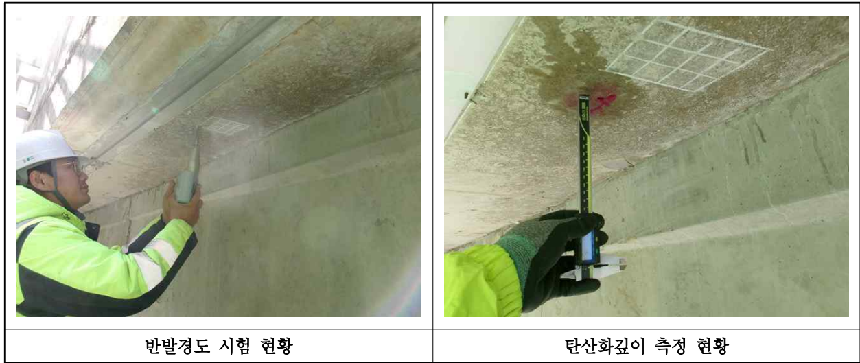
【사진 1.4.1】 콘크리트 내구성조사 현황
