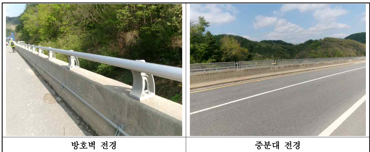
【사진 1.3.23】 방호벽 및 중앙분리대 전경
