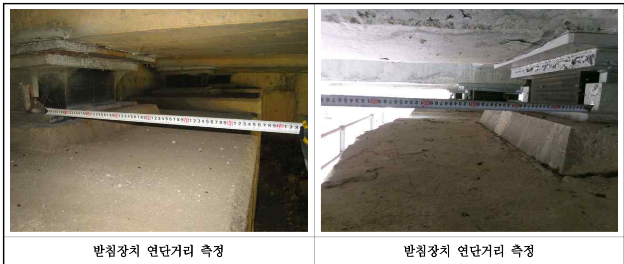
【사진 1.3.14】 교량받침장치 연단거리측정
