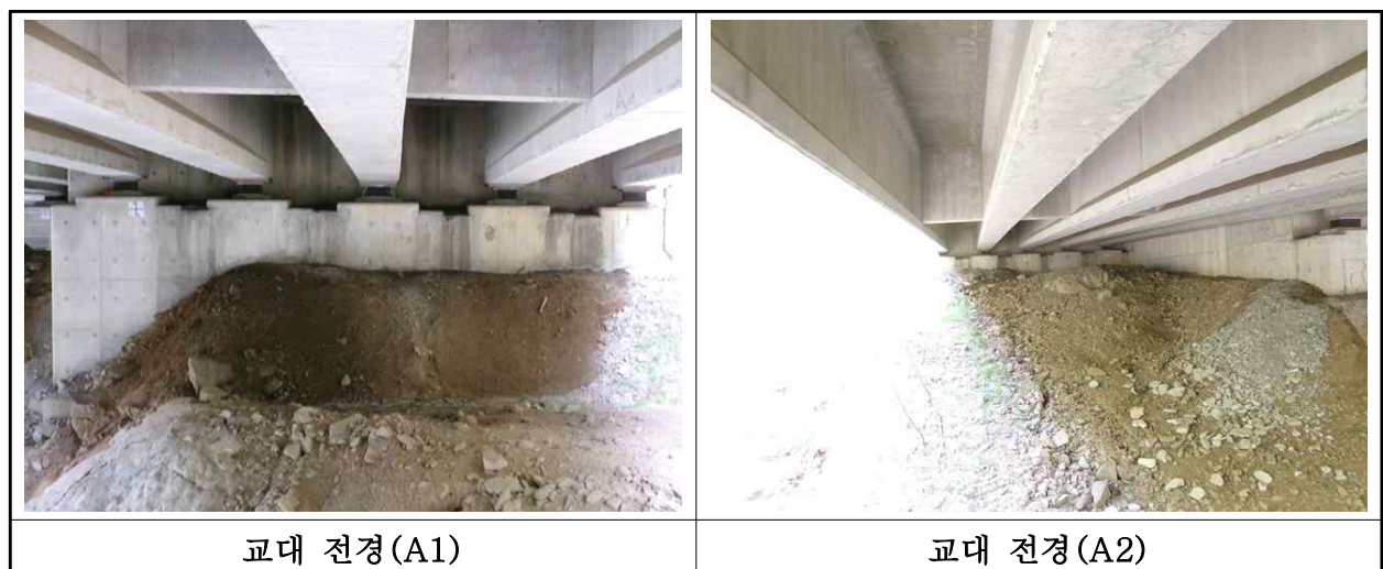
【사진 1.3.8】 교대 전경
