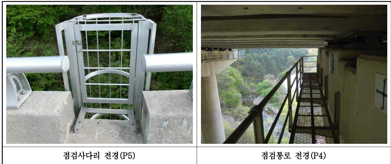
【사진 1.3.25】 교량 점검시설 전경
